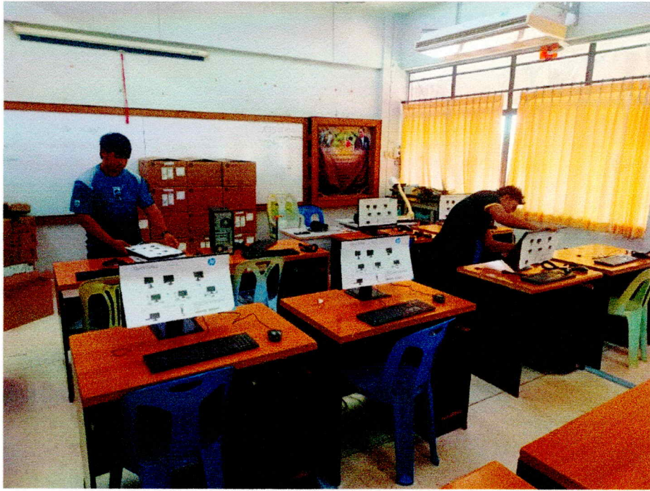
ภาพการติดตั้งคอมพิวเตอร์
